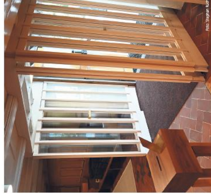
Bei der Sanierung des Kirchenraums hat sich die Behörde eingebracht.
